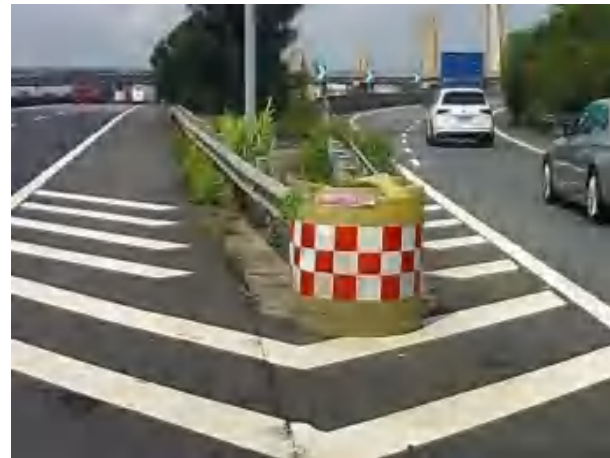
图3-6 部分分流三角端护栏现状
